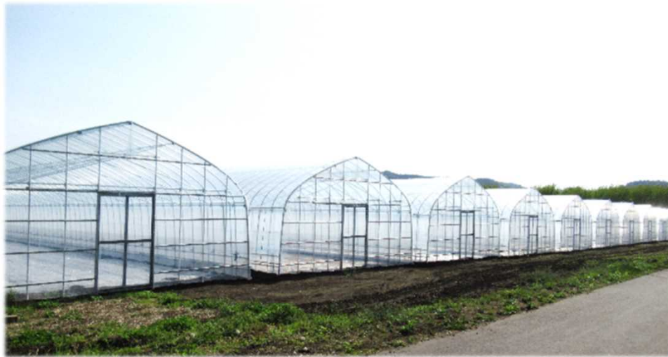
R3にモデル団地事業の一環として 常陸大宮市三美地区 に参入した (株)カモスフィールド のほ場（パイプハウス 61棟）
