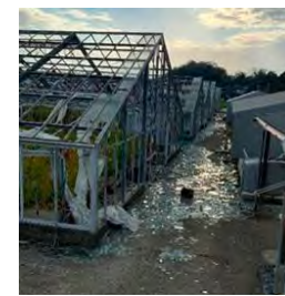
被災したガラスハウス (令和元年房総半島台風 に伴う大雨)
