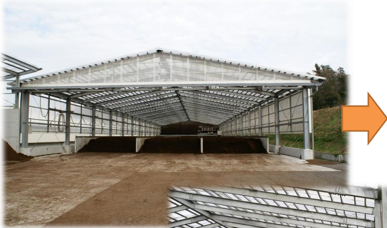
醗酵槽 (堆肥の完熟化)
