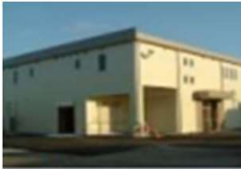
集出荷施設の整備
